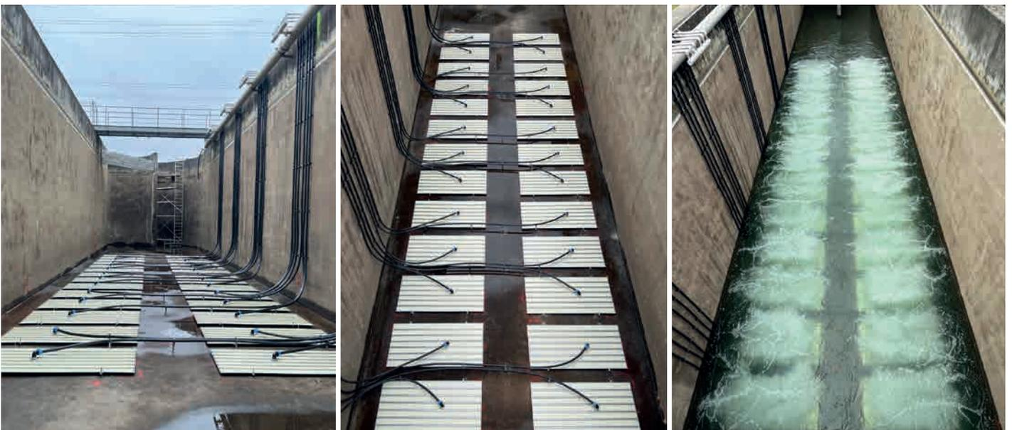
Die Bakterien im Belebungsbecken müssen stets mit Sauerstoff versorgt werden. Eine neue Lüftungsanlage optimiert den zukünftigen Energiebedarf der Kläranlage. ■
