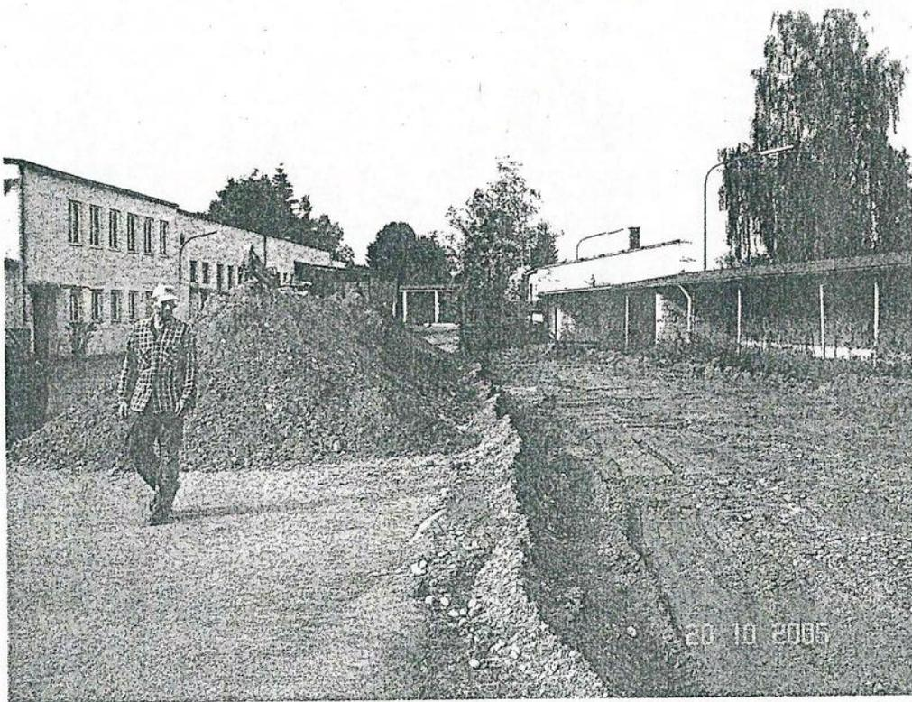
Abb. 1: Haufwerk (links) und Aushubplanum (rechts) nach Abschleifen einer ca. 30 cm starken Bodenschicht am 20.10.2006.
